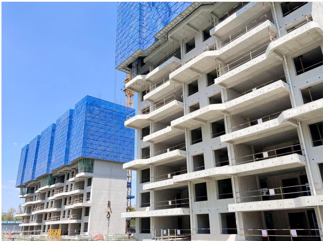
在施工过程中，项目管理团队严格执行《陕建八建集团项目标准化管理手册》，积极采用拉杆式型钢悬挑架、井道施工电梯、附着式脚手架等施工技术，秉持“策划先行、样板引路、过程控制、一次成优”的质量管理理念和“零隐患是我们永远的追求，零事故是我们的终极目标”的安全理念，
