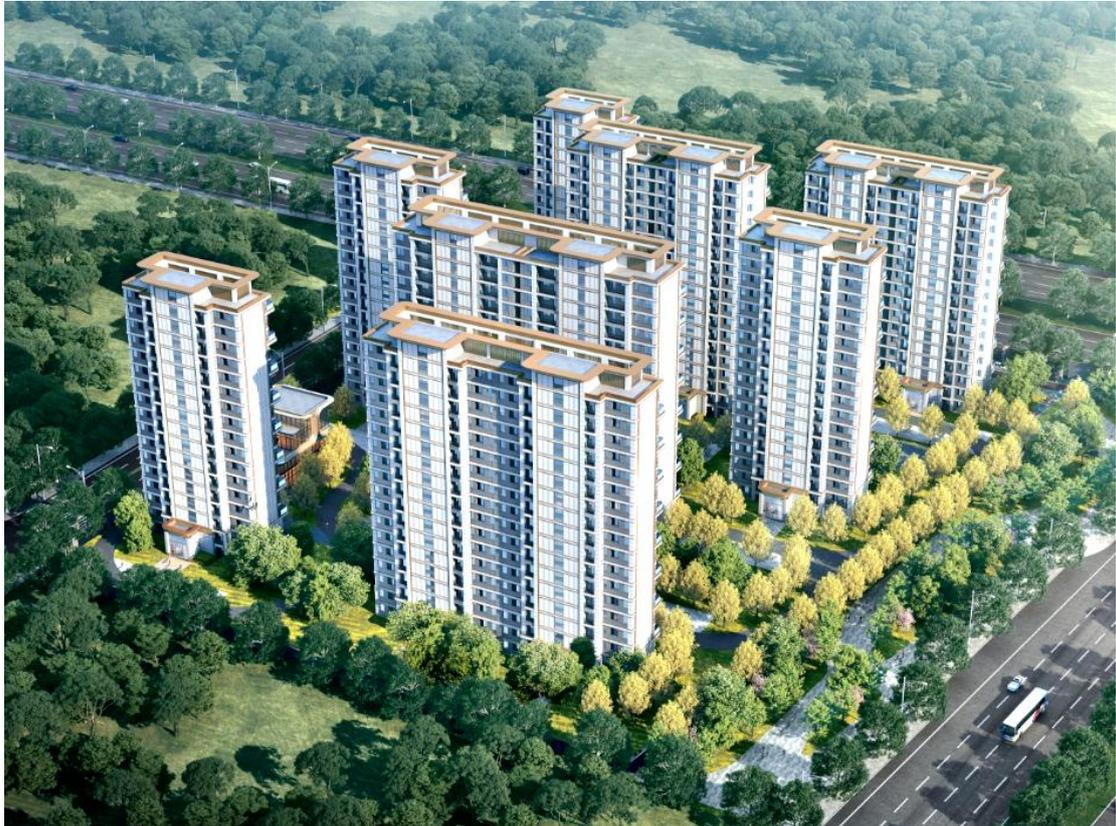
翰林府项目位于西安市未央区明光路以东、元朔路以北。该项目包含 8 栋住宅、3 栋商业配套建筑，主楼采用 CFG 复合地基，筏形基础，剪力墙结构；车库采用天然地基+局部换填、独立基础，车库及商业配套均为框架结构。（陈玺龙张瑞康）
