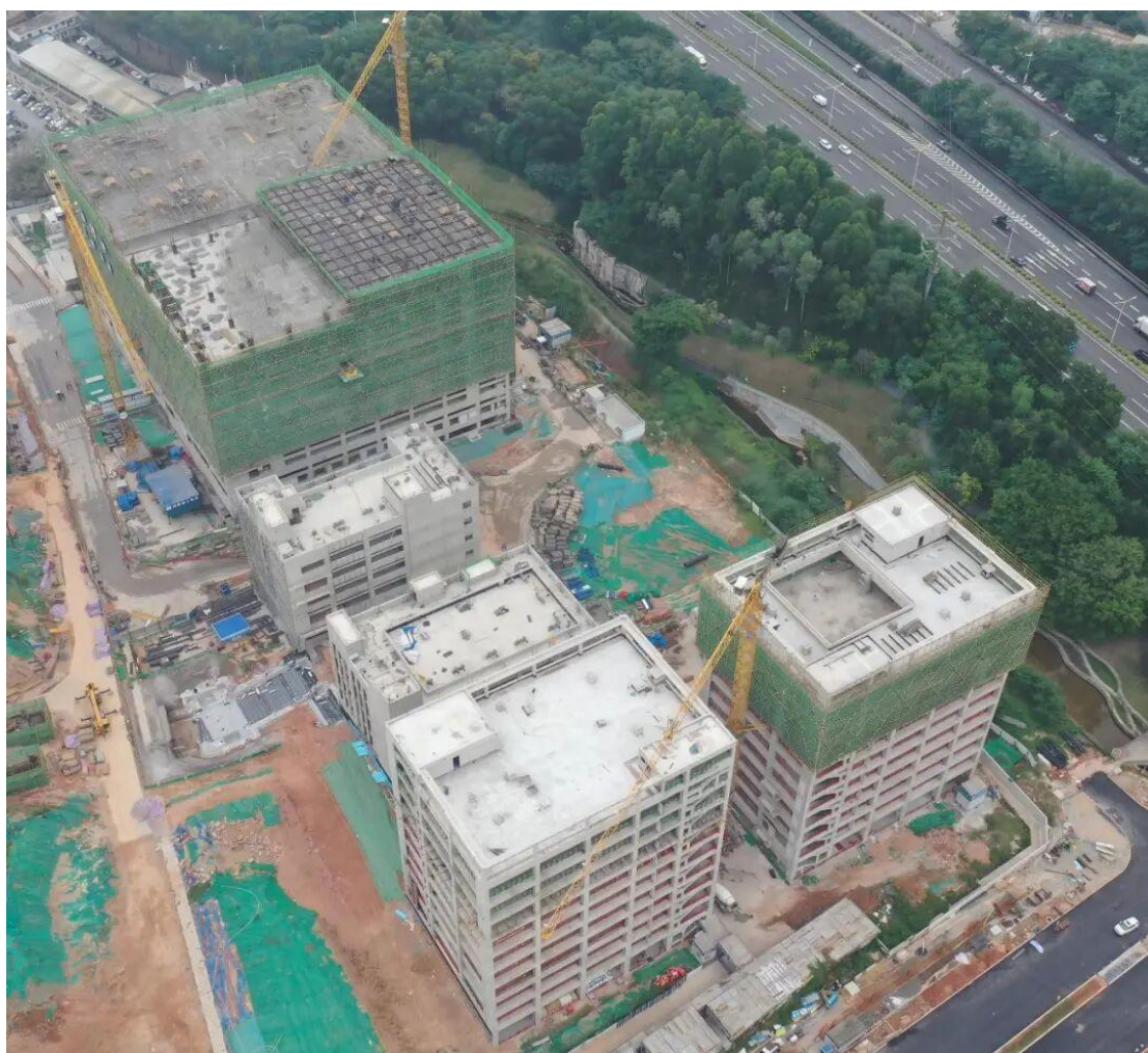
迈瑞医疗供应链科技园二期主体项目
