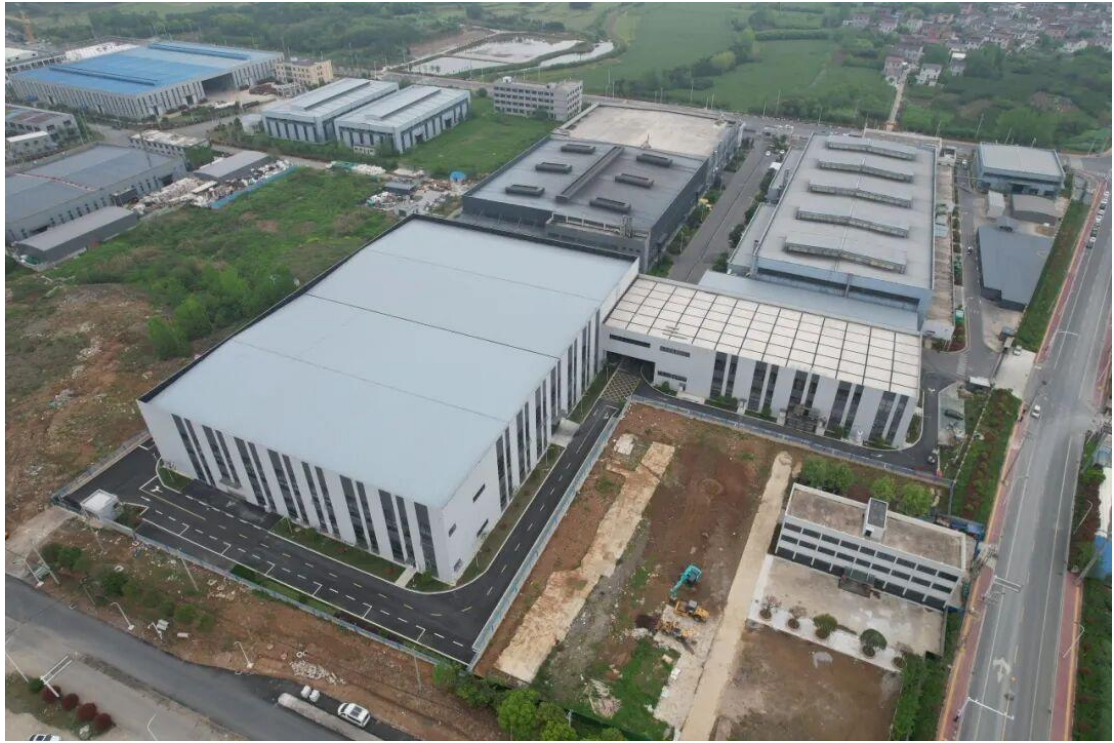
▲ 含山金桥产业合作园二期项目-T-2 厂房竣工
