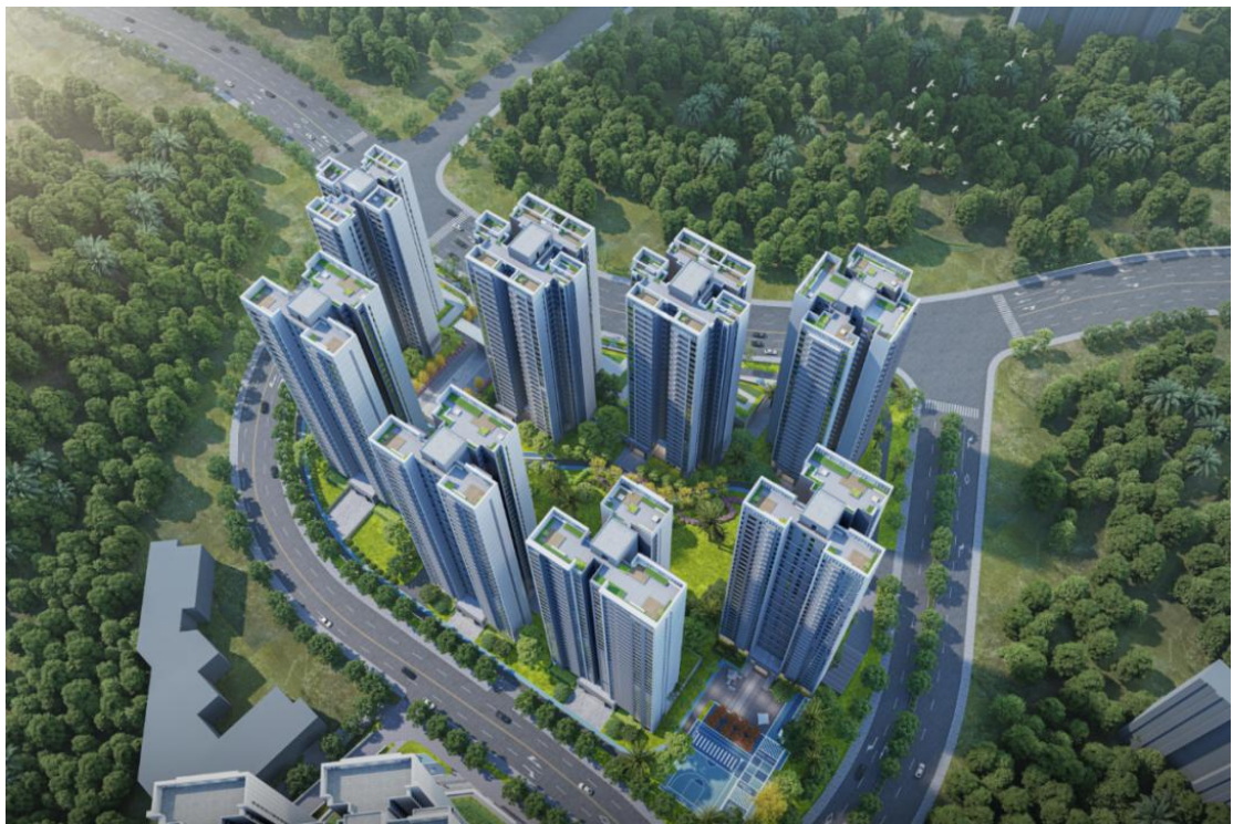
▲广州市黄埔区云埔街笔岗社区宏岗 城中村改造项目复建 AZ-02 地块工程
