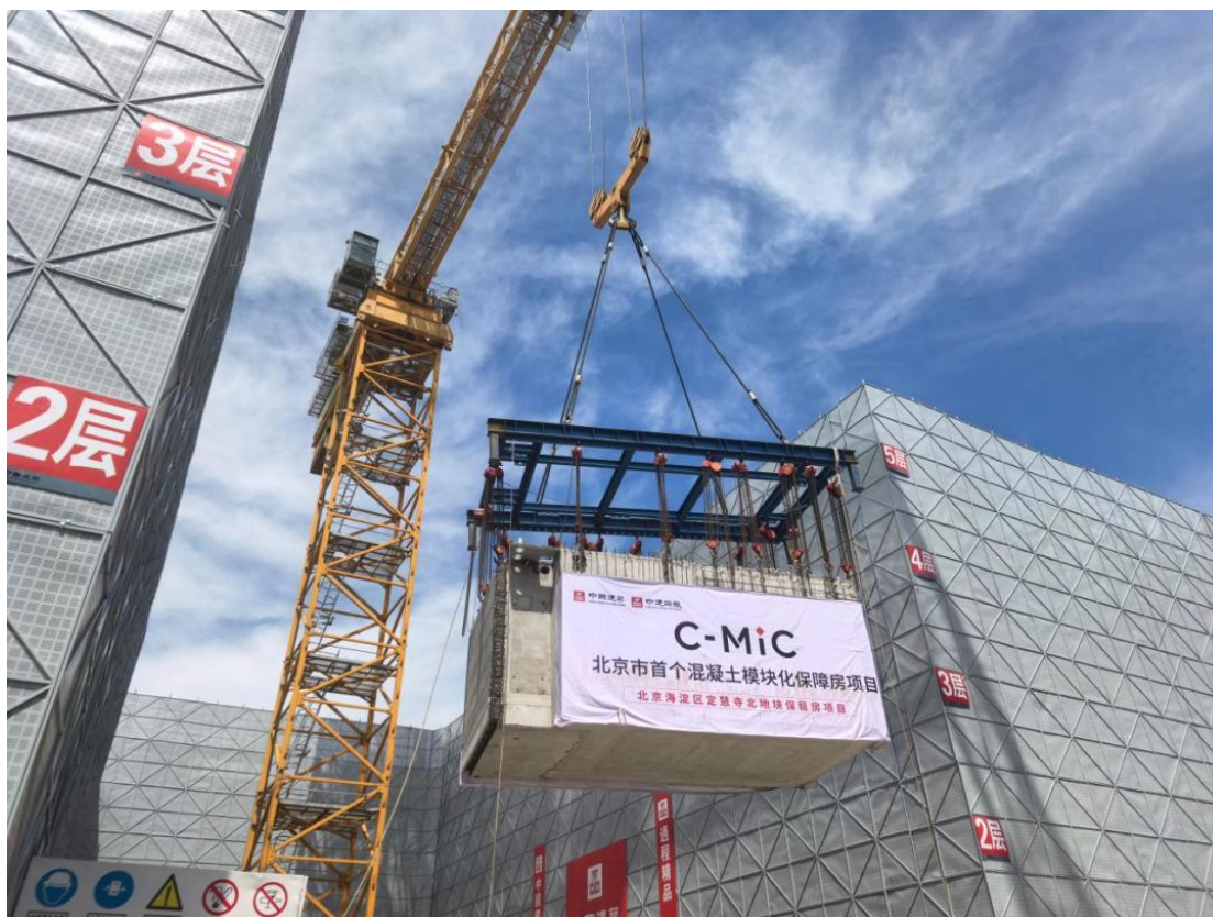
6月26日，北京海淀区定慧寺北地块保租房项目智能建造-MiC技术吊装现场。新华网记者李连章摄
