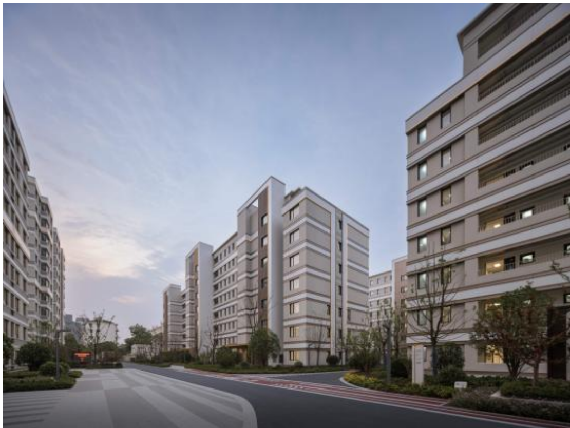
2026年6月，上海徐汇区田林路65弄旧住房拆除重建项目交付。图片由采访对象提供
