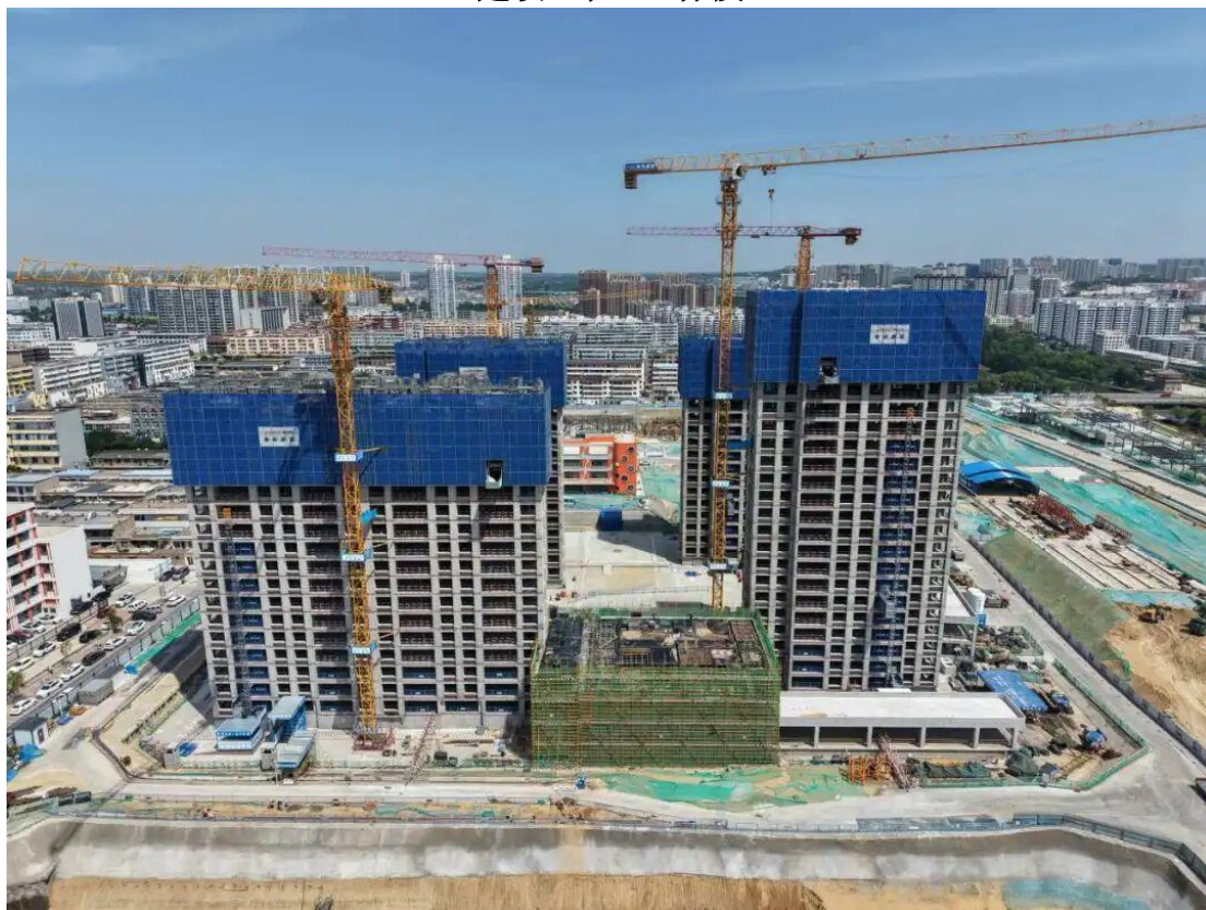
榆林市榆阳区小西沙棚户区改造项目 建设工程 N1 标段
