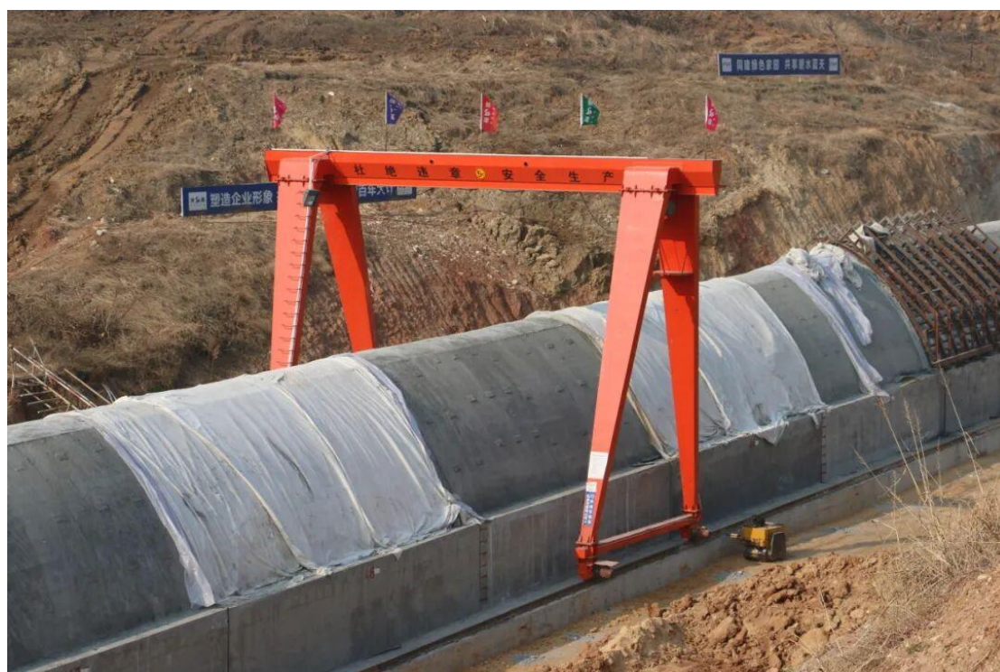
▲俭沟排洪涵洞工程
