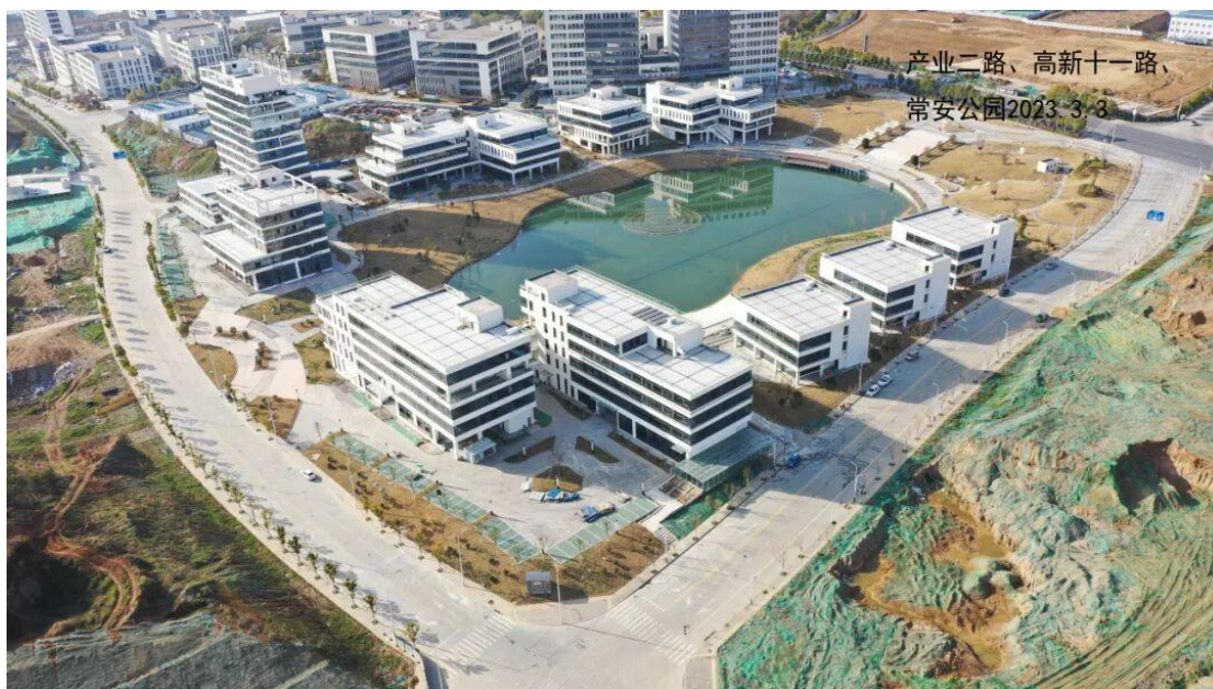
▲安康高新飞地经济产业园一期路网工程项目
