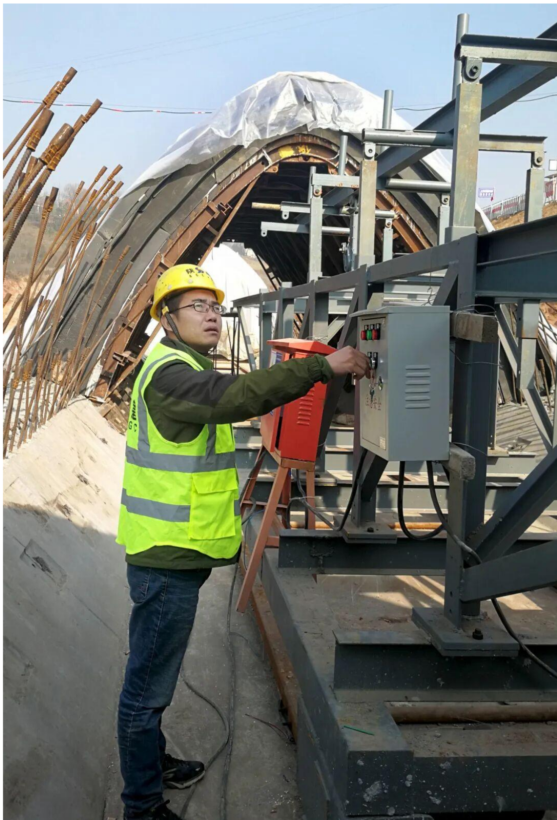
▲项目钢筋台车发明专利成果在俭沟涵洞施工中的应用
