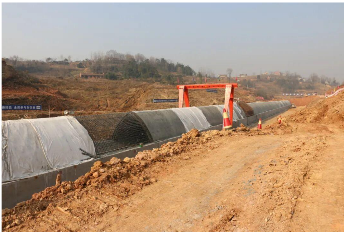
▲ 俭沟排洪涵洞工程
